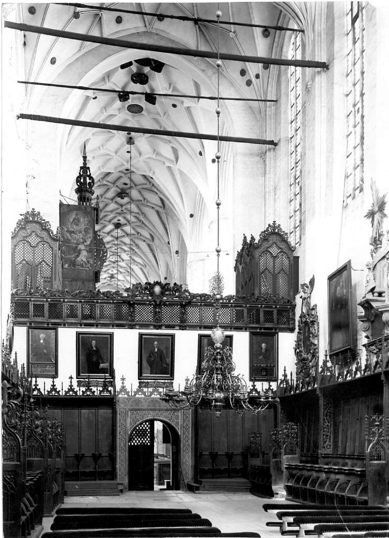
Prezbiterium, widok od strony wschodniej, przed 1944
