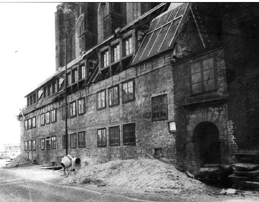
Budowa budynku kurii provincialnej, koniec lat 80. XX w.
