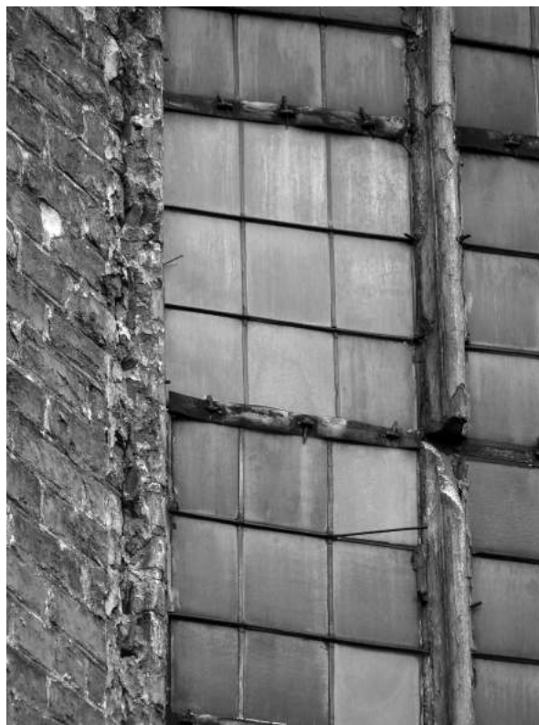
fragment okna przed konserwacją
